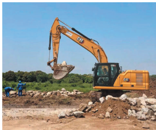
Mais de 50 trabalhadores estão envolvidos na execução das obras da primeira fase do aeroporto
