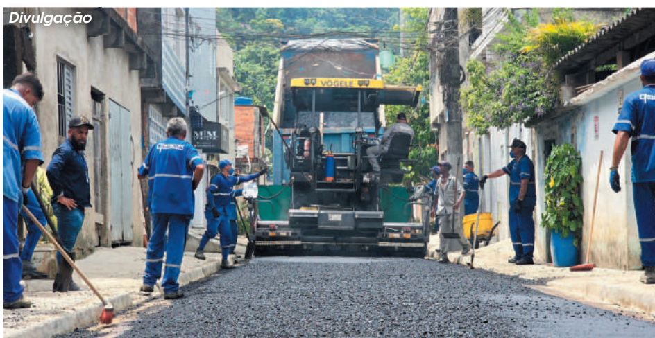
Serviços realizados incluíram drenagem, revitalização de guias, sarjetas e calçadas
