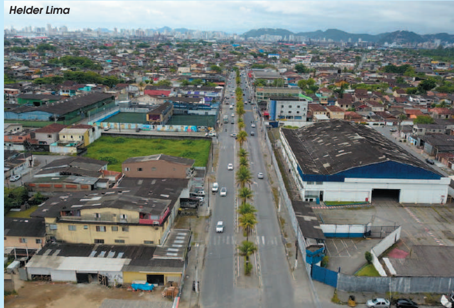
Intervenções provocarão desvios no tráfego em diferentes pontos da Cidade
