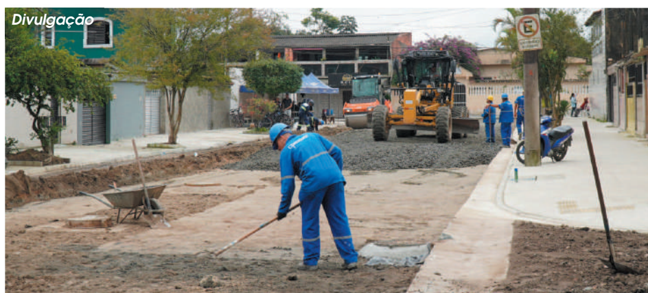
Pacote contempla quatro ruas e reúne pavimentação, calçadas acessíveis, drenagem e implantação de guias e sarjetas
